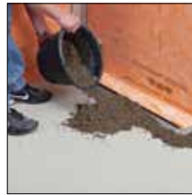
=> 5. Réaliser la chape avec forme de pente
