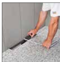
=> 4. Prendre les mesures pour le carrelage du support à carrelé...
