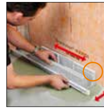
=> 1. Ajuster le support de caniveau
