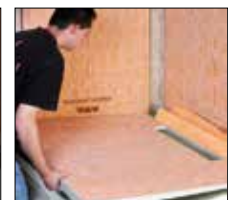
=> 3. Pousser le receveur en pente sous le bord du corps de caniveau
