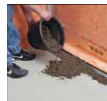
=> 3. Mise en œuvre de la chape de mise à niveau
