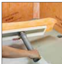
=> 2. Mettre en place le tuyau d'évacuation
