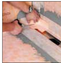
=> 2. Coller la collerette KERDI Découper l'angle rentrant KERECK
