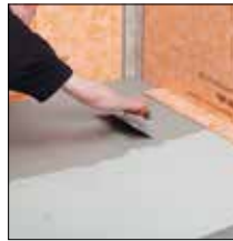
=> 6. Déposer du mortier-colle
