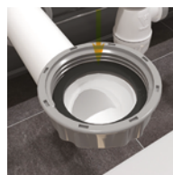
Joint surmoulé en bonne position
