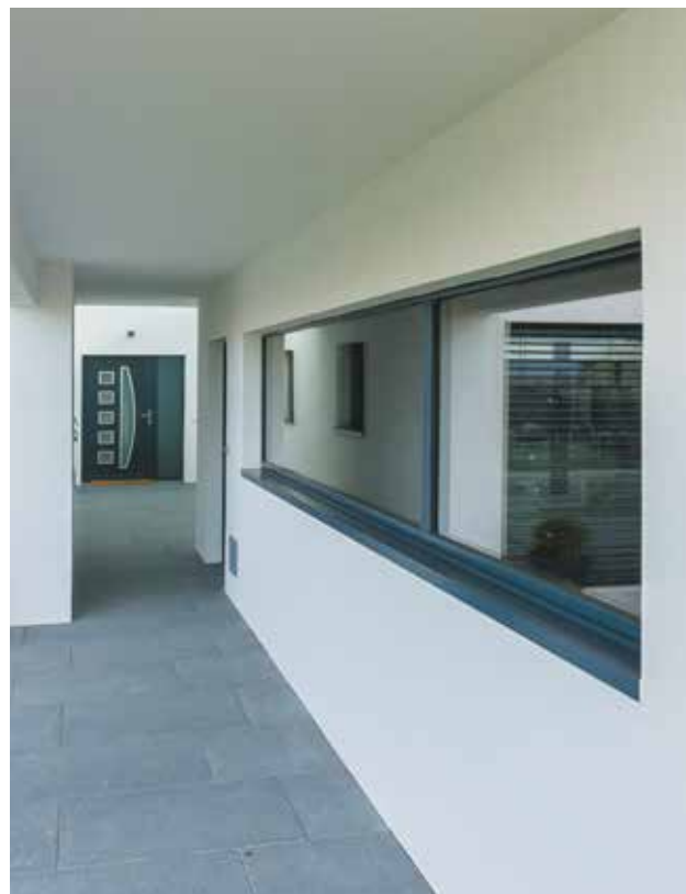
maison individuelle, Truchtersheim (67) - photographe Grégory Tachet Porotherm GF R20
