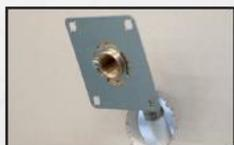
**4** Fixer le coude d'encastrement sur la platine sans les serrer. Ne jamais plier les canalisations FLUXO®.
