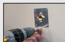
**7** Fixer la platine à l'aide des vis et des chevilles. Retirer les vis lorsque les chevilles sont expansées.
