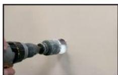
**1** Percer un trou de 67 mm de diamètre dans la cloison de plâtre à l'aide d'une scie cloche.
