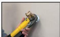
**3** Positionner les coudes sur les tubes et réaliser le sertissage.
