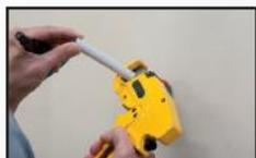
**2** Sortir les tubes FLUXO® par les trous et ajuster la longueur des tubes de façon à pouvoir positionner la pince.
