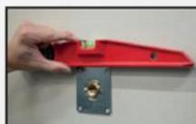
**5** Placer la platine horizontalement à l'aide d'un niveau.
