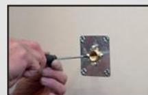
**8** Serrer de façon définitive les vis de fixation des coudes sur la platine.
