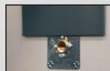
**9** La platine, par son épaisseur réduite, sera facilement noyée dans le ciment colle utilisé pour la pose de la faïence.
