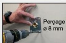
**6** Percer les quatre trous de fixation dans la cloison en veillant à ne pas percer le tube.
