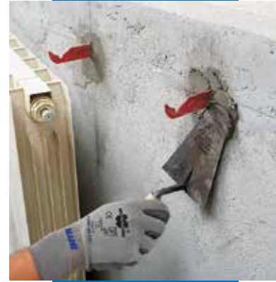
Fixation de supports pour radiateur avec Mortier Express
