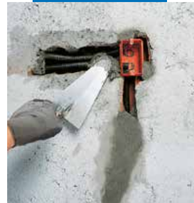
Fixation de boîtes et de fourreaux électriques avec Mortier Express
