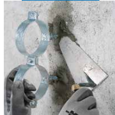
Fixation de colliers pour canalisation avec Mortier Express
