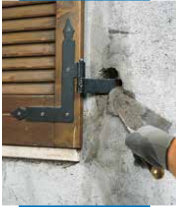
Fixation de gonds avec Mortier Express
