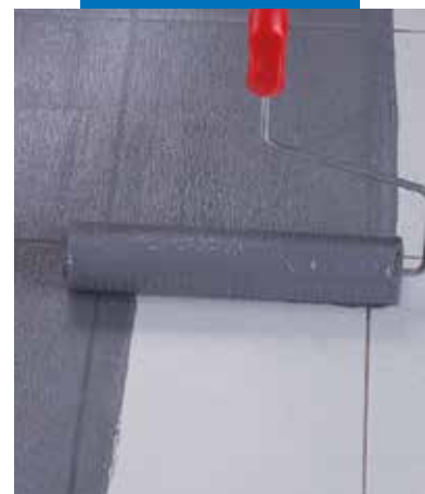
Application d'Eco Prim Grip Plus au rouleau sur un ancien carrelage en porcelaine
