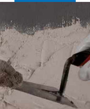
Application d'un enduit sur Eco Prim Grip Plus
