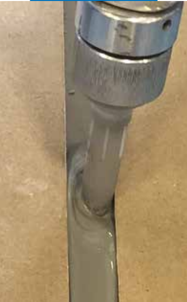
Application à la pompe de Mapeflex SPP
