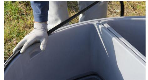
**6** Reposer le couvercle du dispositif de traitement en positionnant face à face les repères du couvercle et de la rehausse.
