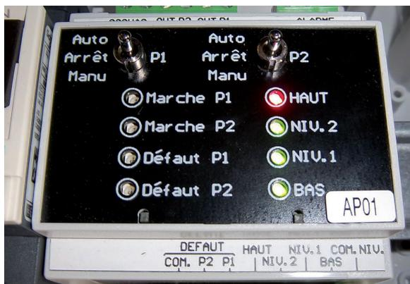
Les régulateurs de niveau sont réglés en usine : si nécessaire, réglez leur débattement angulaire (cf. notice de la pompe). Il est possible de forcer la marche de chacune des deux pompes en positionnant les boutons sur «Manu». En fonctionnement normal, positionnez les boutons sur «Auto».
