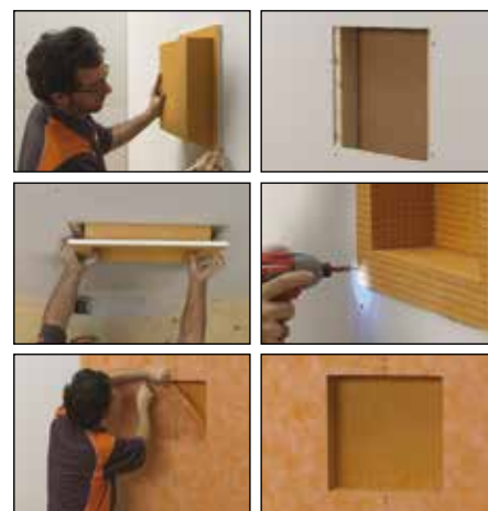
Intégration dans des plaques de plâtre
