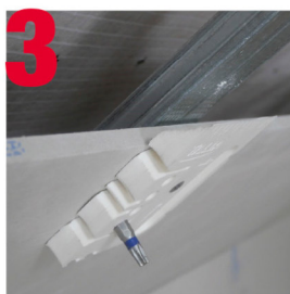
3 Maintien de la plaque en pose rampant
