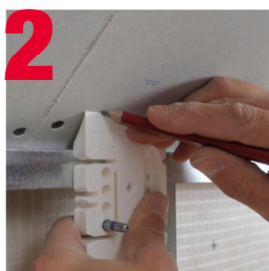
2 Biseau pour tracer/ mesure plaque sous rampants.
