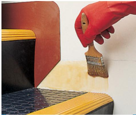
Application de plinthes en caoutchouc avec Adesilex LP
