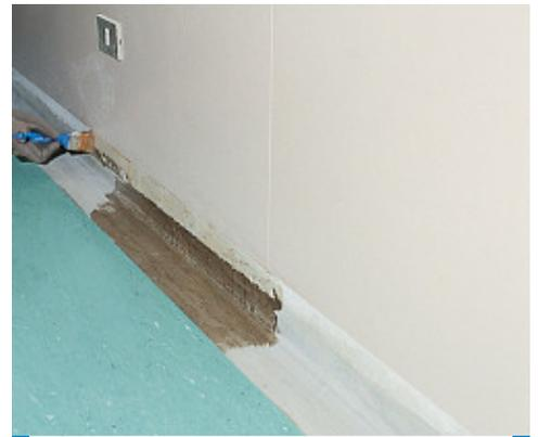
Installation de la bande de rive Liuni PVC avec Adesilex LP
