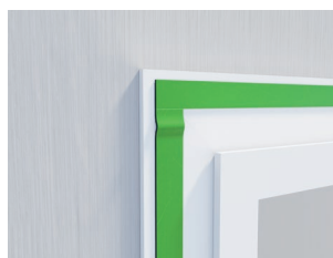
Respecter une surlongueur de 1 cm par jonction
