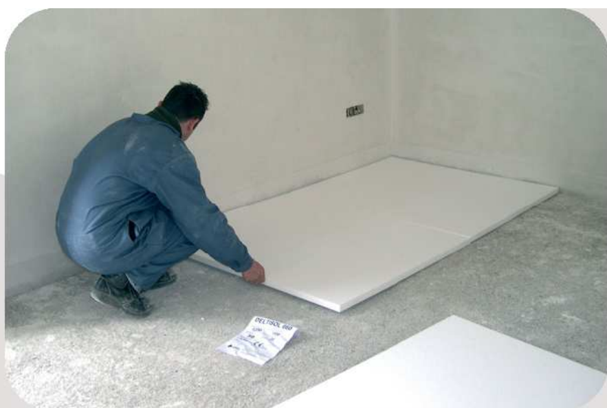
revêtement de sol collé
