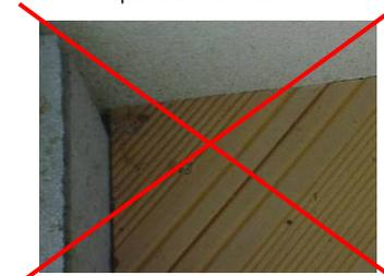
Laisser un joint de dilatation de 5 mm entre les lames et de 15 mm par rapport à un mur
