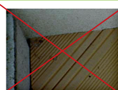
Laisser un joint de dilatation de 5 mm entre les lames et de 15 mm par rapport à un mur ou un obstacle.
