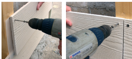
④ Ne pas oublier la bande à joint sur le chevron à la jonction de 2 clins
