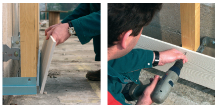
② Pose et fixation de la première rangée de clins
