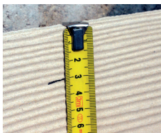
③ Recouvrement de 30 mm
