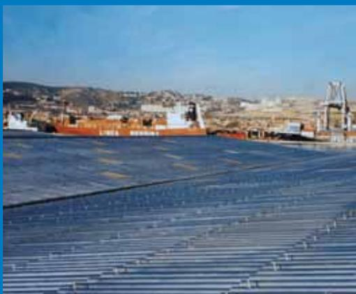
**Curnoir®** est un enduit semi-liquide d'étanchéité à base de bitume élastomère, de charges minérales et de solvants volatils.
