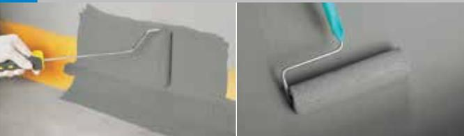
Recouvrir **Alsan® Toile de Renfort** d'une couche d'**Alsan® 500** en remontant au dessus de la toile de renfort (hauteur du relevé ≥ à 10 cm). Appliquer au rouleau une couche d'**Alsan® 500** en surface courante. Renouveler l'opération une fois\*. \*Deux fois en cas de trafic important ou si la terrasse domine des locaux fermés (3 couches de 600 g/m<sup>2</sup>).
