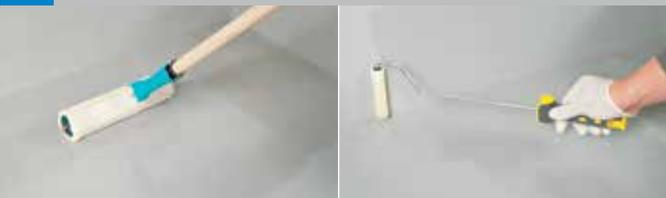
Appliquer **Alsan® Primaire H80** au rouleau en passes croisées sur l'ensemble des surfaces et sur les relevés. L'aspect final doit être brillant, sinon une nouvelle couche de primaire doit être appliquée.
