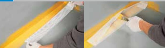
Appliquer **Alsan® 500 Colle** à l'aide d'une spatule ou d'un pinceau au droit des relevés sur 10 cm en talon et en vertical. Mettre en place **Alsan® Toile de Renfort** de 15 cm de développé, en veillant à bien faire pénétrer la colle à travers la toile.
