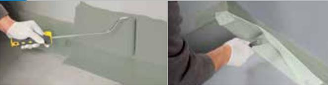
Appliquer une fine couche d'**Alsan® 400** à l'aide d'une spatule ou d'un pinceau, au droit des relevés sur 10 cm en talon et en vertical. Mettre en place **Alsan® Voile de Renfort** de 10 cm de développé en veillant à bien faire pénétrer la résine à travers la toile.
