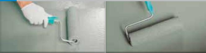
Recouvrir **Alsan® Voile de Renfort** d'une couche d'**Alsan® 400** en remontant au dessus du relevé (*hauteur du relevé ≥ à 10 cm au dessus de la surface circulée*). Appliquer au rouleau une couche d'**Alsan® 400** en surface courante. Renouveler l'opération une fois.
