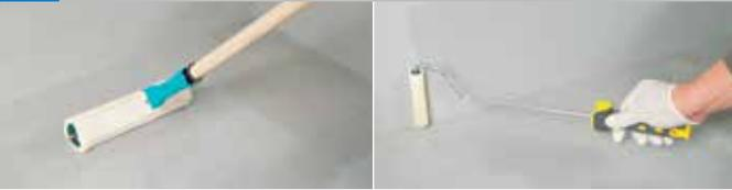
Appliquer **Alsan® Primaire H80**, au rouleau en passes croisées sur l'ensemble de la surface et sur les relevés. L'aspect final doit être brillant, sinon une nouvelle couche de primaire doit être appliquée.
