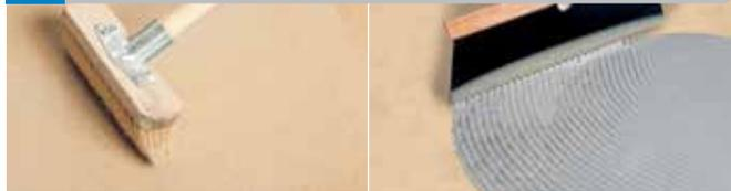
Après séchage de 72 heures minimum, balayer/aspirer pour éliminer le surplus de silice non adhérente. Appliquer directement le carrelage (30 x 30 cm maximum) et la plinthe à l'aide d'un mortier-colle conforme au CPP (par exemple Cermiplus).
