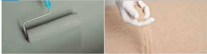
Saupoudrer à refus, frais dans frais dans la dernière couche d'**Alsan® 400**, de l'**Alsan® Silice M** granulométrie (1mm environ), en partie courante comme sur le relevé destiné à recevoir la plinthe.
