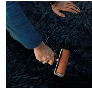
**2. Les recouvrements en bordures et fins de lés de 10 cm doivent être soigneusement marouflés.**
