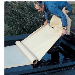
**1. Après avoir positionné la membrane, décoller la sous-face siliconée sur 10 cm, poser l'amorce ainsi réalisée sur le support puis tirer la feuille siliconée pour appliquer le restant du lé. Éviter toute inclusion d'air.**
