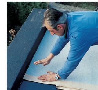
**3. Positionner et dérouler la deuxième couche à joints décalés par rapport à la première couche. Pour Colphène® 2090 AR, enlever la protection du galon avant d'effectuer le recouvrement entre les différents lés.**
