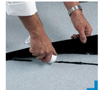
**4. Les recouvrement en bout des membranes Colphène® 2090 AR sont effectués à l'aide de la colle fournie dans chaque rouleau.**
