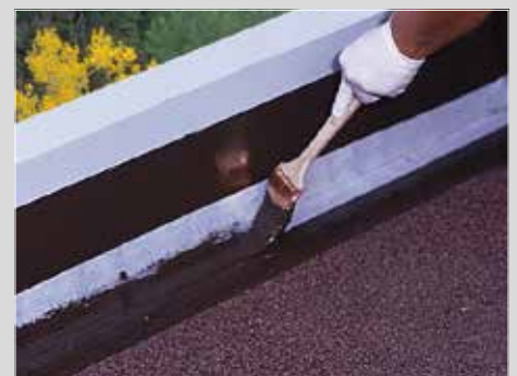
3- Application de la 1 ère couche d' Alsan® Flashing (900 g/m 2 ).
