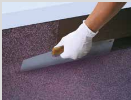
5- Finition (optionnelle) par application au platir de paillettes d'ardoise colorées.
