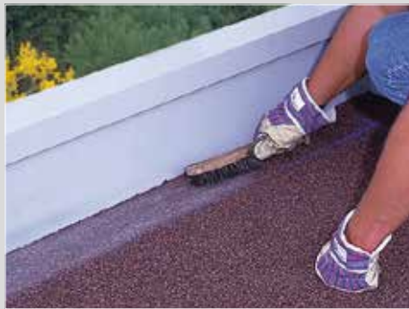
1- Élimination des paillettes d'ardoise à la brosse métallique.
