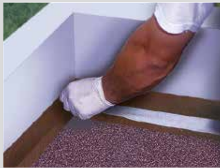
2- Collage de l'armature de renfort Alsan® Voile Flashing (développé 10 cm) à l'aide d' Alsan® Flashing (500 g/m 2 ).
