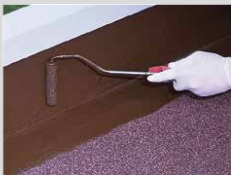
4- Application de la 2 ème couche d' Alsan® Flashing (700 g/m 2 ).
