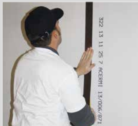
La jonction des panneaux Efimur® est traitée avec le ruban adhésif Air'Stick® .
