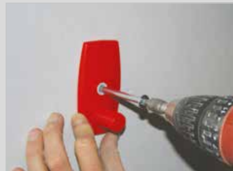
3- Fixer Efi Clic sur le panneau Efimur® .
