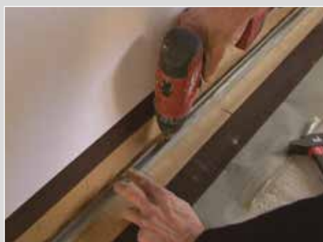
5- Fixer mécaniquement les lisses hautes et basses*.
