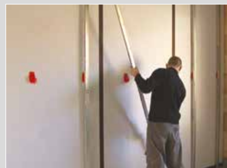
6- Mettre en place la fourrure par clipsage sur Efi Clic .
