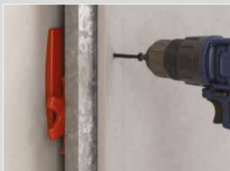
8- Poser les plaques de plâtre.
