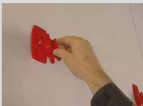
4- Assembler l'appui Efi Clic .
