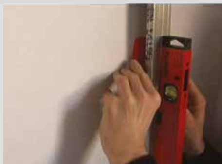
7- Régler la planéité de la fourrure après mise en œuvre de l'isolant thermo-acoustique optionnel.
