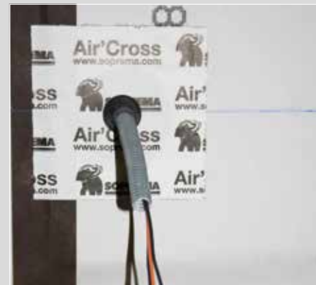
La contre-cloison est montée à l'avancement et favorise le passage des réseaux.
