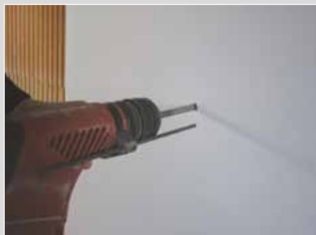
2- Tracer et percer l'emplacement de l' Efi Clic .
