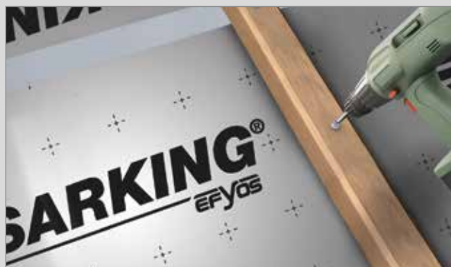
4- Fixation des contrelattes au droit des chevrons avec Efivis SF ou Efivis DF selon l'épaisseur de l'isolation (cf. tableau ci-dessous), puis pose des liteaux.
