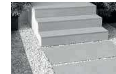
Pose sur gravillon
