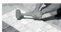
Ajuster la position des pavés à l'aide d'un maillet en caoutchouc.
