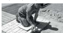
Déplacez-vous à l'aide d'une planche sur les pavés déjà posés.
