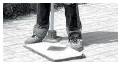
Compacter en utilisant une plaque protégée par un feutre.
