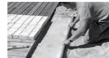
Égaliser le lit de pose à l'aide d'une règle.
