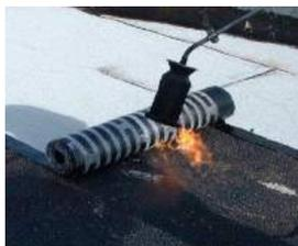
Feuille d'étanchéité semi-indépendante sous enrobés. L'usage de la technique de la semi-indépendance permet de limiter l'apparition de gonfles.
