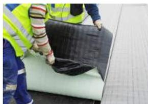
Feuille d'étanchéité semi-indépendante autocollante sous asphalte. La technique de la semi-indépendance permet de limiter l'apparition de gonfles.
