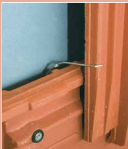
Crochet de pannetonnage latéral et vis bardage inox avec anneau EPDM
