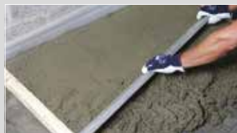
b- Appliquer le béton en une couche de minimum 5 cm et l'égaliser à l'aide d'une règle.
