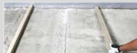
c- Mise en place des cales de niveau.
