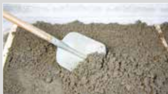
a- Pas d'armature dans le ravaillage.
