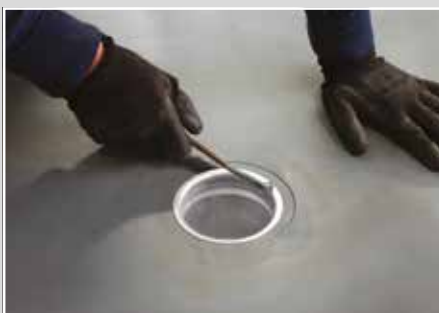
4- Contrôler la soudure à l'aide du Flag Welding Tester .
