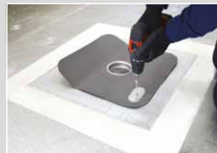
3- Fixer mécaniquement la platine Draini® Flag . Une fixation à chaque angle.
