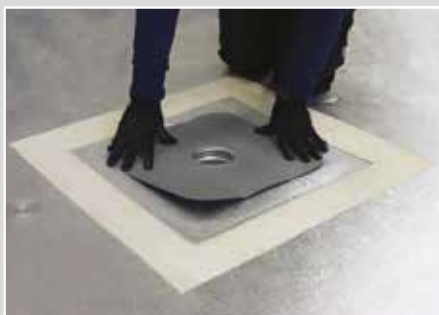
2- Insérer Draini® Flag dans la réservation après avoir installé la membrane d'étanchéité, uniquement dans le cas de membrane feutrée.
