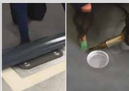
4- Souder par thermo-soudure
