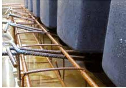
Insérer un tor de Ø 16 mm de longueur 2,3 m dans chacun des passages sous la cuve (BIO4 = 1 fer, BIO5 et BIO6 = 2 fers).
