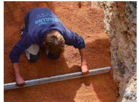
Si le sol n'est pas porteur réaliser un béton de propreté parfaitement de niveau.
