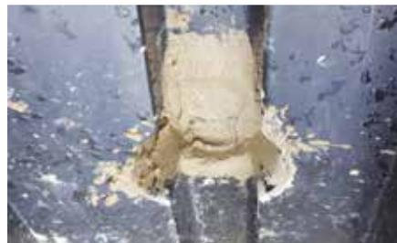
Rajouter environ de 2 seaux pour remplir totalement le tube vertical.
