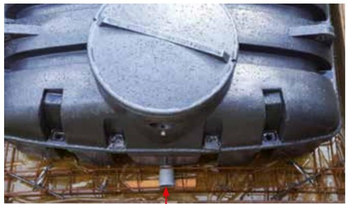
Tuyau de sortie à connecter à un autre filtre avec une pompe ou d'un poste de relevage (à ancrer également à son lestage).
