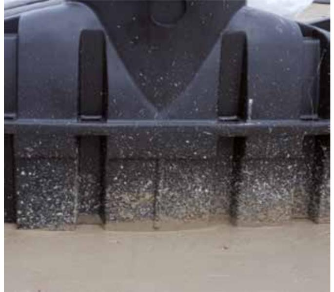
Remplir autour de la cuve avec du sable ou un matériau granulaire (ex : 0/6, 2/4 ou autre granulométrie  $\leq$  10 mm).
