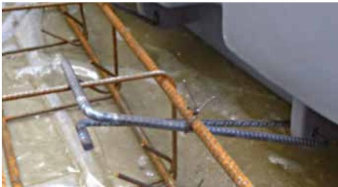
La canalisation de sortie de cuve sera prise dans la ceinture béton et prolongée jusqu'à un autre filtre avec une pompe intégrée ou jusqu'à un poste de relevage installé après le filtre. Le poste de relevage devra être également lesté.
