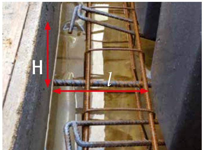
Insérer le fer tor Ø 16 mm dans chaque passage traversant en fond de filtre.
