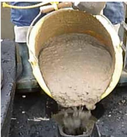
Après 6 à 8 seaux de 10 litres, on observe l'émergence du béton au niveau des 4 liaisons sous la cuve selon des tas plus ou moins gros.
