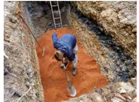
Sur un sol porteur déposer un lit de sable de 10 cm d'épaisseur parfaitement de niveau.
