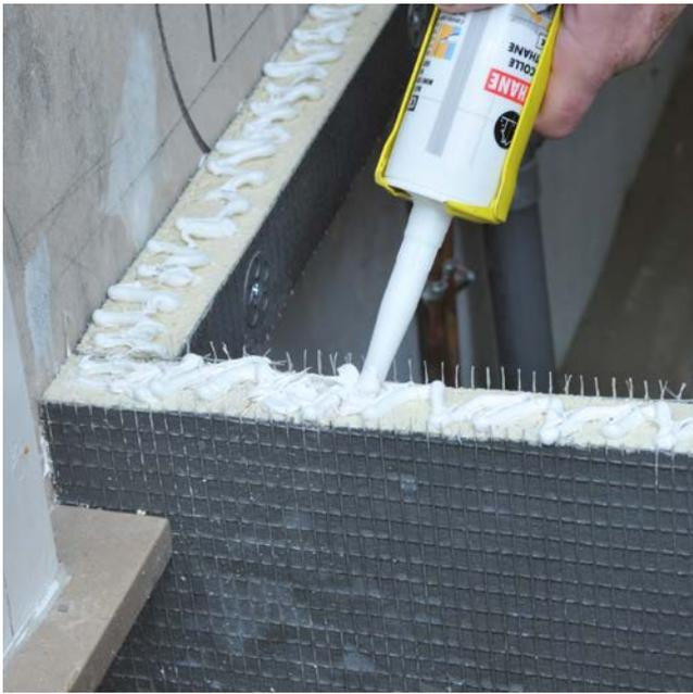
Appliquer à l'aide d'un pistolet mécanique un cordon de Cermithane sur le chant du ou des jambage(s) et sur les morceaux de soutien.
