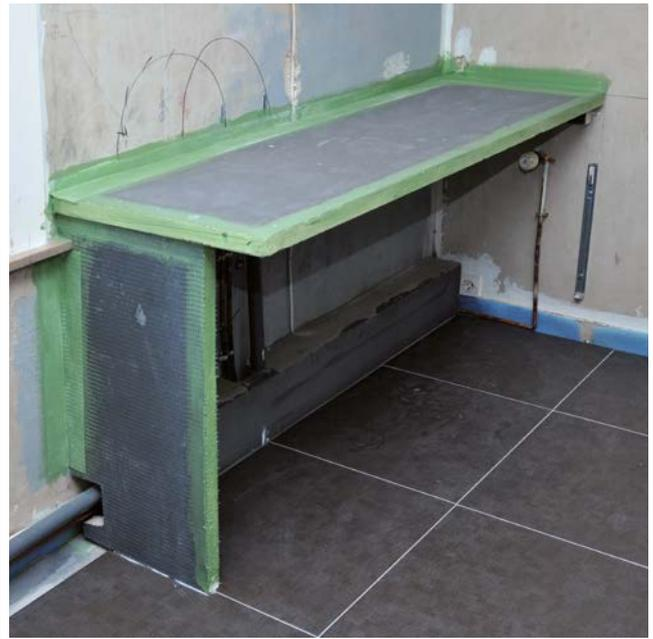
Armer toutes les jointures et chants des panneaux avec la bande d'armature AR12 et le Cermicryl.
