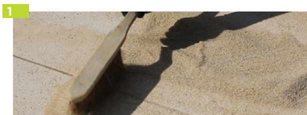
Pose sur sable : Procéder au remplissage des joints des dallages au sable (pas d'utilisation de sable polymère).
