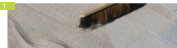
Employer un sable fin qui sera soigneusement balayé dans les interstices entre les pavés.
