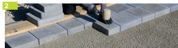
Ajuster la position des pavés à l'aide d'un maillet en caoutchouc.
