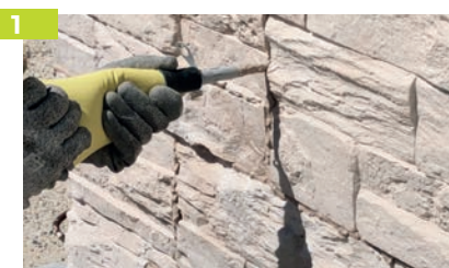
Jointer à la poche à joints.
