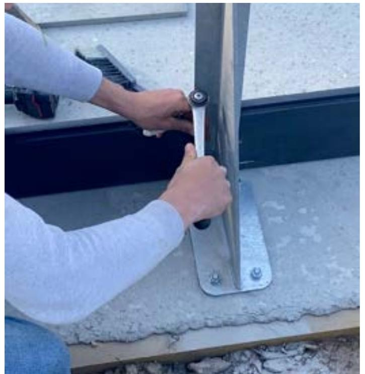
Placez ensuite les goujons d'ancrage (avec rondelles et écrous) dans les trous et frappez-les à l'aide d'un marteau. Enfoncez entièrement les goujons d'ancrage (seule la tête doit rester visible). Serrez fermement en croix les 4 écrous à l'aide d'une clé à dynamométrique ou d'une clé à pipe.
