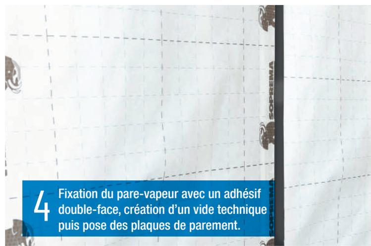
**4** Fixation du pare-vapeur avec un adhésif double-face, création d'un vide technique puis pose des plaques de parement.
